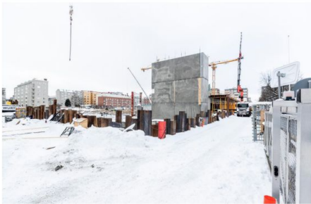
Tammelan stadionin koko alkaa hahmottua, kun pysäköintihallin perustustyöt on saatu tehtyä.
